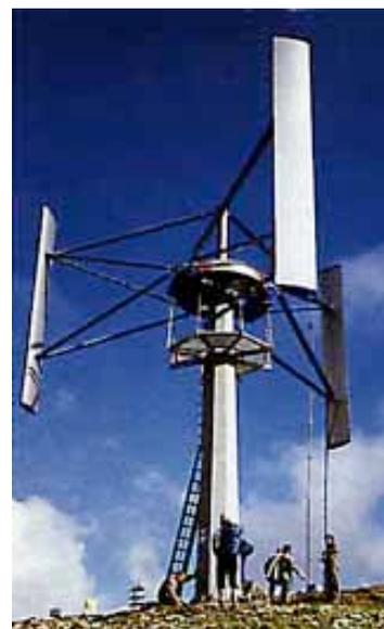
Abb.8: Die H-Bauform des Darrieus Rotors [9]
