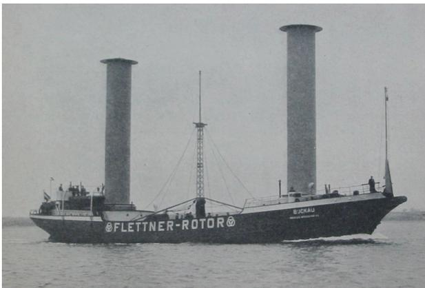
Abb.26 Schiff, angetrieben durch den Flettner-Rotor [15]
